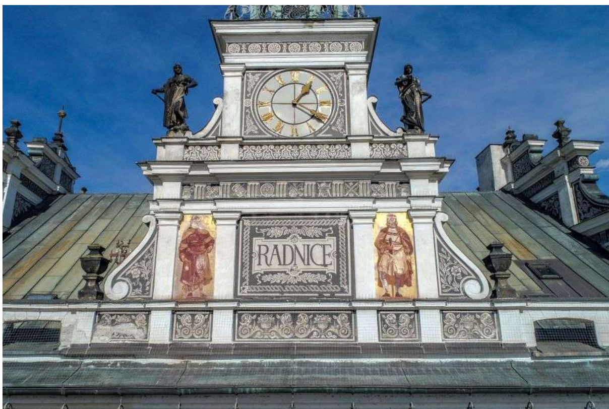
Vpravo ke staré budově přiléhá nižší - Nová radnice. Původně zde byla kasárna. V roce 1884 tuto budovu koupila obec a nechala zde vystavět budovu ve stejném stylu jako vedlejší- podle návrhu architektů Jana Vejrycha a Jana Zeyera. Na průčelí stojí dvě sochy – Rytíř a socha
